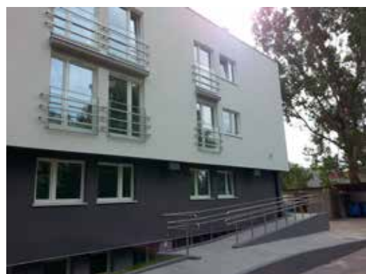
Wyremontowana część pawilonu z podjazdem dla chorych
