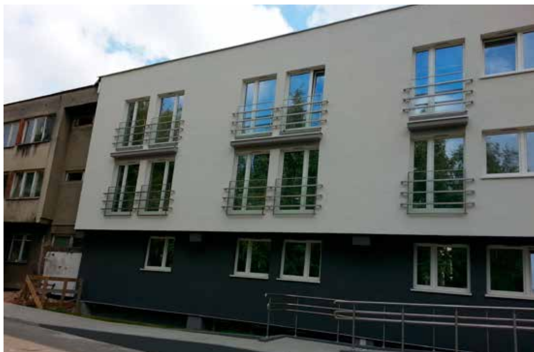
Częściowo wyremontowany pawilon nr 4
